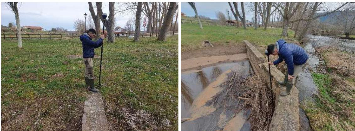
*Levantamiento topográfico del muro de mampostería de la piscina con GPS Emlid Reach3.*
