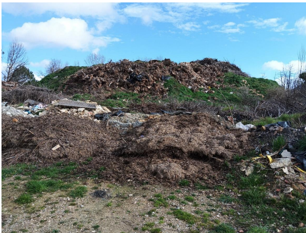
Foto 6. Aspecto del talud desde la entrada suroeste de la parcela.
