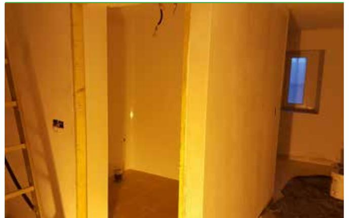
Reforma total del baño, acondicionamiento de suelos y paredes, pintura completa del local, línea nueva de luz, etc...
